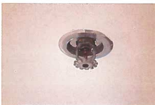
ระบบหัวกระจายน้ำดับเพลิงอัตโนมัติ
