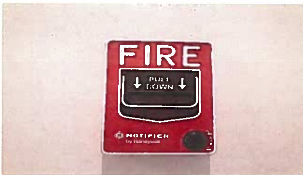
กริ่งสัญญาณเตือนภัย เครื่องแจ้งเหตุโดยใช่มือดึง
