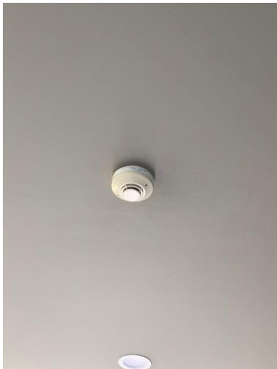
ภาพที่ 57 แสดงเครื่องตรวจจับควัน (Smoke Detector)
