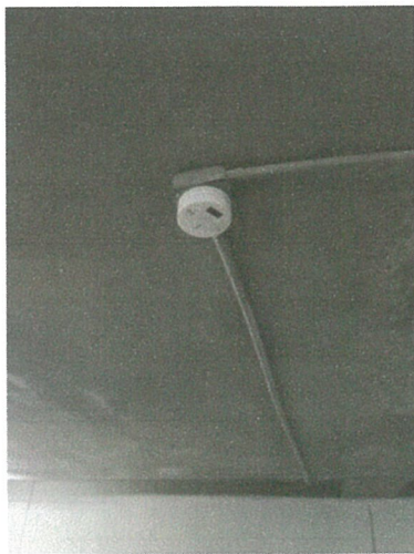
รูปภาพที่ 2.52 เครื่องตรวจจับความร้อน
