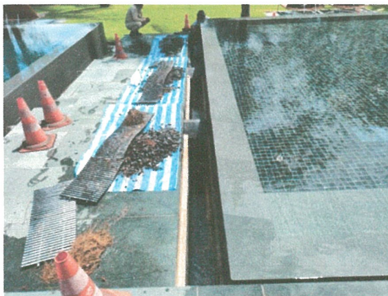
รูปภาพที่ 2.21 การขุดลอกตะกอน
