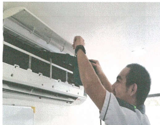
รูปภาพที่ 2.28 การล้างทำความสะอาดแอร์
