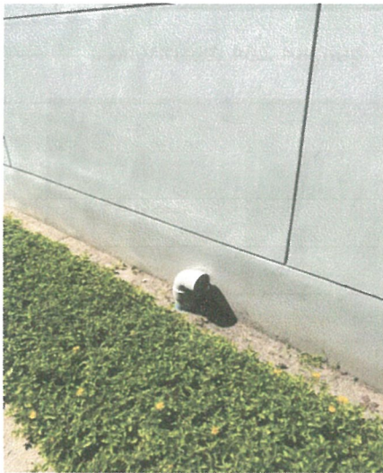
รูปภาพที่ 2.59 ท่อสำหรับระบายก๊าซมีเทน
