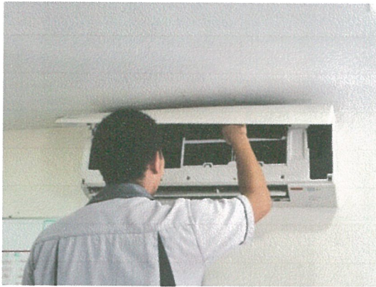
รูปภาพที่ 2.28 การล้างทำความสะอาดแอร์
