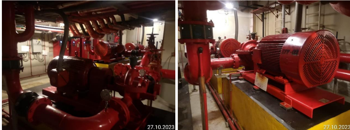
รูปที่ 2-7 เครื่องสูบน้ำดับเพลิงแบบขับเคลื่อนด้วยไฟฟ้า
