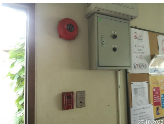
รูปที่ 3-7 อุปกรณ์แจ้งเหตุที่ใช้มือ
