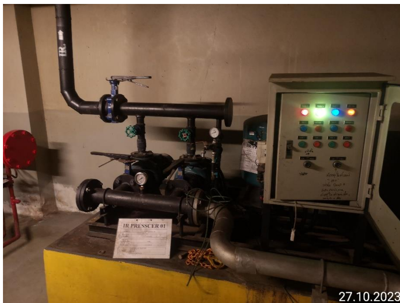
รูปที่ 3-12 เครื่องสูบน้ำหมุนเวียนกลับมาใช้ใหม่และถังเก็บน้ำหมุนเวียนกลับมาใช้ใหม่
