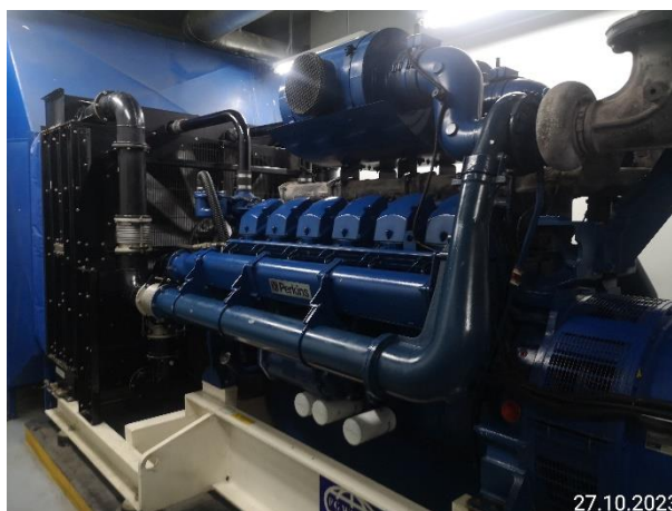
รูปที่ 3-15 เครื่องยนต์ผลิตไฟฟ้าสำรองใช้ดีเซล ขนาด 1,200 kW
