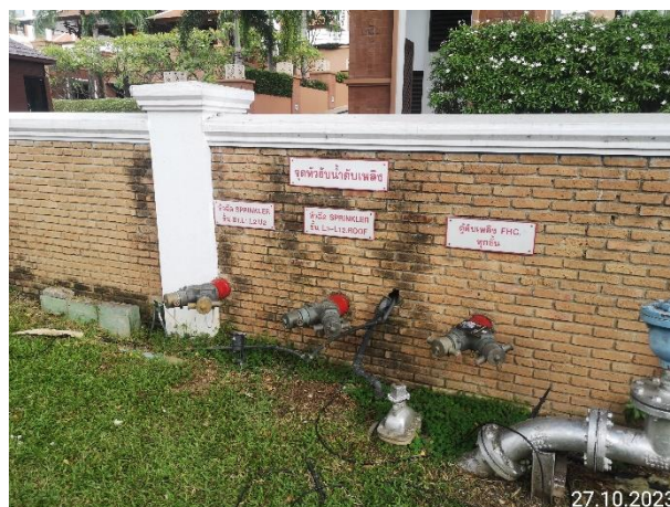
รูปที่ 3-14 หัวรับน้ำดับเพลิงชนิดข้อต่อสวมเร็วติดตั้งภายนอกอาคาร
