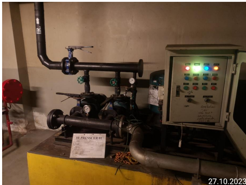
รูปที่ 2-5 เครื่องสูบน้ำหมุนเวียนกลับมาใช้ใหม่และถึงเก็บน้ำหมุนเวียนกลับมาใช้ใหม่
