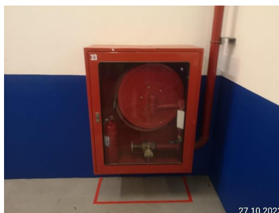
รูปที่ 3-8 ตู้ดับเพลิงและเครื่องดับเพลิงแบบมือถือ
