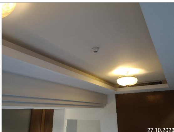
รูปที่ 3-6 อุปกรณ์ตรวจจับควันไฟ
