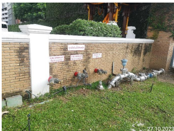
รูปที่ 3-14 หัวรับน้ำดับเพลิงชนิดข้อต่อสวมเร็วติดตั้งภายนอกอาคาร
