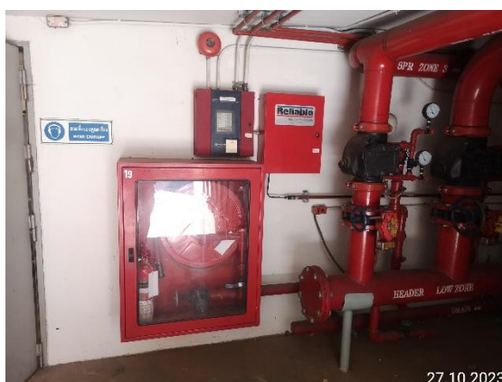
รูปที่ 3-8 ตู้ดับเพลิงและเครื่องดับเพลิงแบบมือถือ
