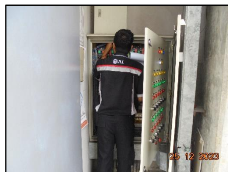
รูปที่ 2-38 มิเตอร์ไฟฟ้าแยกเฉพาะสำหรับระบบบำบัดน้ำเสีย ของโครงการ
