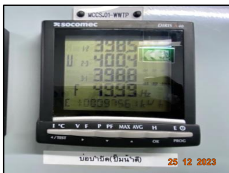
รูปที่ 2-38 มิเตอร์ไฟฟ้าแยกเฉพาะสำหรับระบบบำบัดน้ำเสีย ของโครงการ
