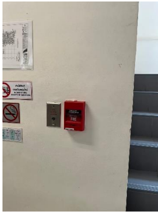
Telephone Jack และ Manual Station
