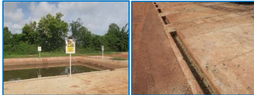
รางระบายน้ำและบ่อคอนกรีตเก็บน้ำ (Concrete Pit)
