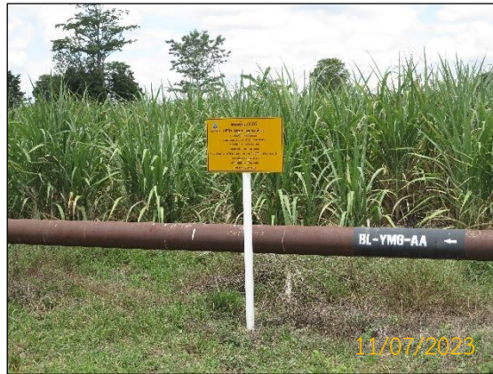
ภาพที่ 2.2-4 ป้ายเตือนสะท้อนแสงแสดงตำแหน่งแนววางท่อ
