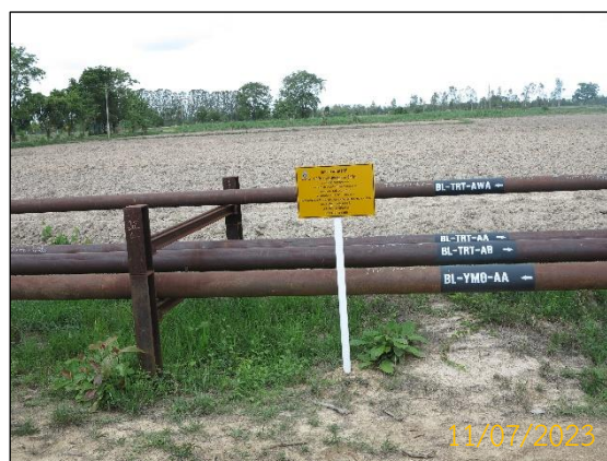
ภาพที่ 2.3-7 ป้ายเตือนสะท้อนแสงแสดงตำแหน่งแนววางท่อ
