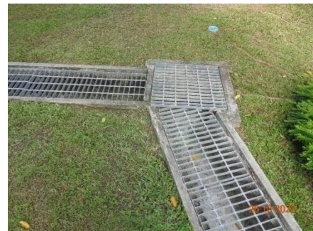
ภาพที่ 2.2-13 ตะแกรงดักมูลฝอย
