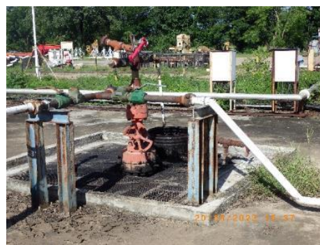
รูปที่ 2-25 สภาพภายในพื้นที่หลุมอัดกลับน้ำ WB-1
