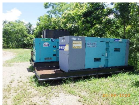
รูปที่ 2-6 เครื่องกำเนิดไฟฟ้าที่ใช้ในโครงการและถังเก็บน้ำมันเชื้อเพลิงพร้อมถาดรอง
