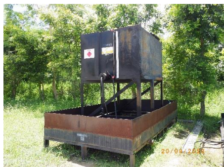
รูปที่ 2-6 เครื่องกำเนิดไฟฟ้าที่ใช้ในโครงการและถังเก็บน้ำมันเชื้อเพลิงพร้อมถาดรอง
