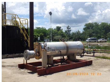
รูปที่ 2-3 อุปกรณ์แยกของเหลว-ก๊าซ (Separator) และ Knock Out Drum
