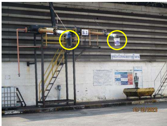
รูปที่ 2-4 ภาพขณะรับการรั่วไหล ของกากน้ำตาล
