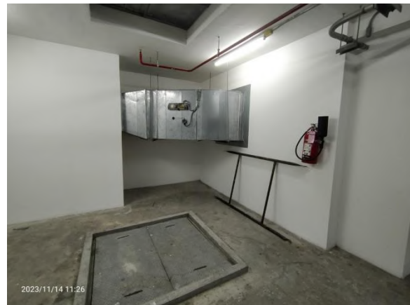
พัดลมอัดอากาศภายในอาคารของโครงการ
