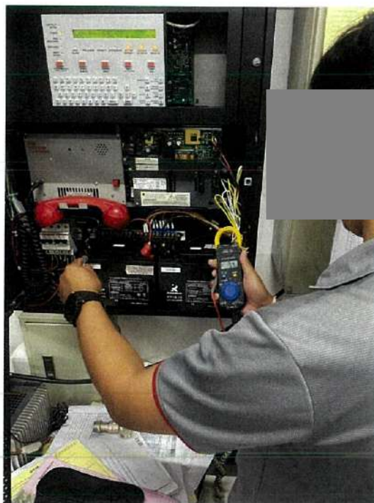
ภาพแสดง การตรวจเช็คการทำงานของ FCP
