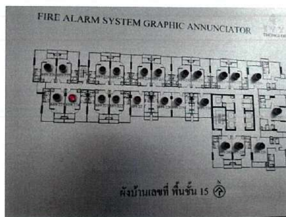
ภาพแสดง การทำงานของตู้ Graphic Annunciator
