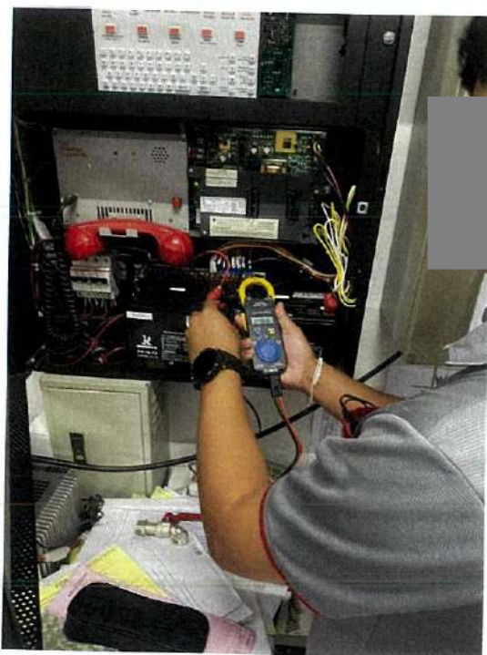
ภาพแสดง การตรวจเช็คการทำงานของ FCP และ Battery
