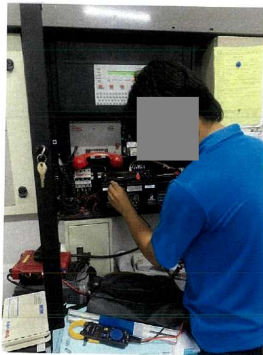
ภาพแสดง การตรวจเช็คและทำความสะอาดตู้ FCP
