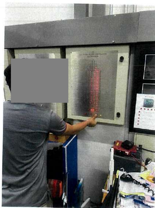
ภาพแสดง การตรวจเช็คการทำงานของ Graphic Annunciator
