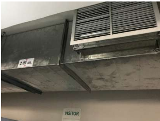
ภาพที่ 2-2 พัดลมดูดอากาศสถานจอดรถใต้ดิน
