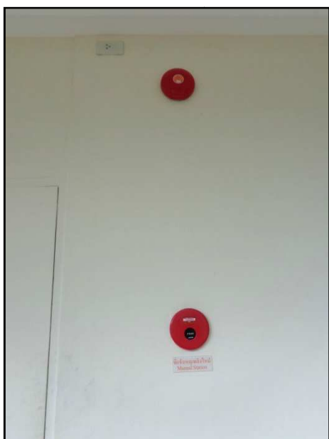
ภาพที่ 1-13 อุปกรณ์แจ้งเหตุเพลิงไหม้แบบมีกอด และอุปกรณ์ส่งสัญญาณชนิดกระดิ่ง
