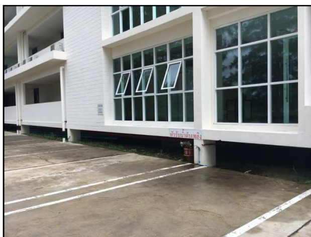
ภาพที่ 2-13 แบบอาคารมีพื้นที่เปิดโล่ง เพื่อให้อากาศถ่ายเทได้สะดวก
