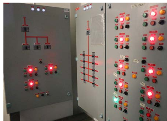
รูปที่ 2-14 สวิตช์แยกระบบบำบัดน้ำเสีย
