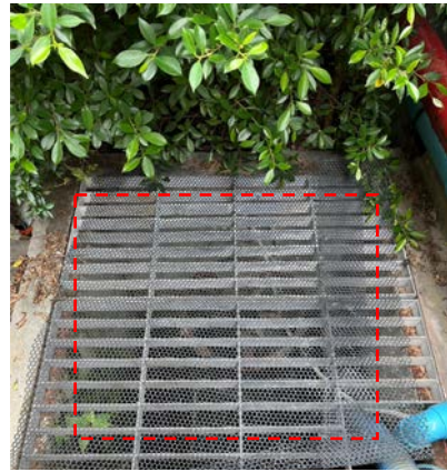
รูปที่ 2-26 ตะแกรงดักมูลฝอยบริเวณบ่อพักน้ำ
