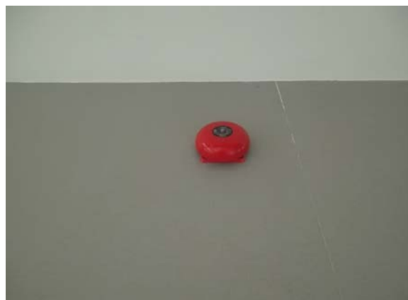
รูปที่ 2-73 สัญญาณเตือนภัยแบบกริ่ง (Alarm Bell)
