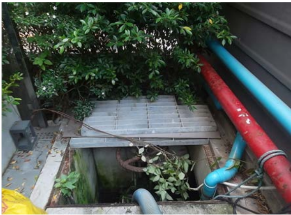
รูปที่ 2-25 บ่อพักน้ำก่อนปล่อยสู่สาธารณะ
