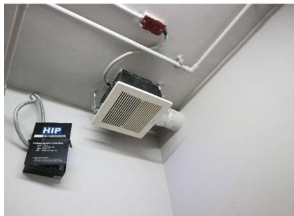
รูปที่ 2-39 ระบบระบายอากาศภายในห้องพักมูลฝอย
