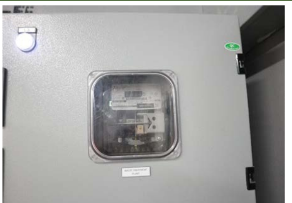
รูปที่ 2-14 มิเตอร์ไฟฟ้าสำหรับบำบัดน้ำเสีย
