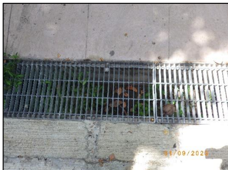
รูปที่ 2-23 รางระบายน้ำภายนอกอาคาร
