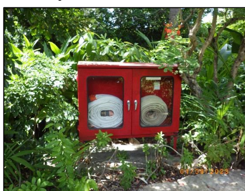
รูปที่ 2-37 ตู้เก็บอุปกรณ์ดับเพลิงภายนอกอาคาร
