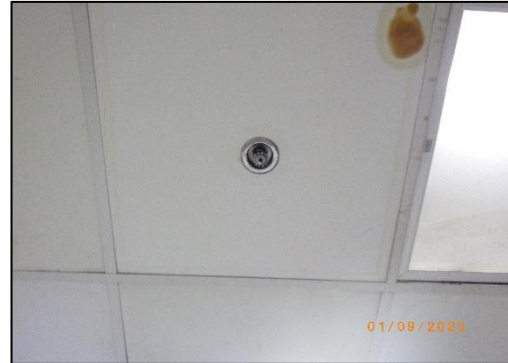
รูปที่ 2-46 หัวฉีดน้ำอัตโนมัติ
