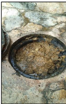
รูปที่ 2-25 การดูแลทำความสะอาดบ่อตกไขมัน
