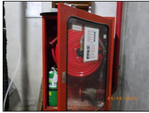
รูปที่ 2-38 ตู้เก็บอุปกรณ์ดับเพลิงภายในอาคาร
