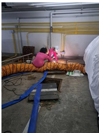
รูปที่ 2-7 สุ่มตะกอนส่วนเกินจากระบบบำบัดน้ำเสียไปกำจัด
