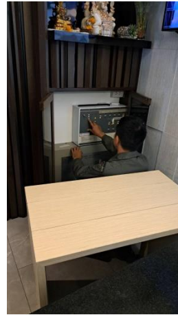
รูปที่ 2-22 ตรวจสอบระบบป้องกันและอัคคีภัย
