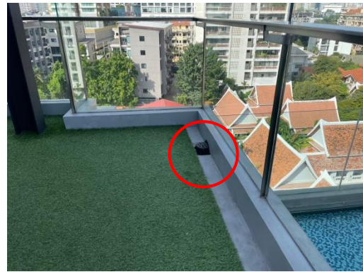
รูปที่ 2-37 ตะแกรงครอบระบายน้ำทิ้ง
