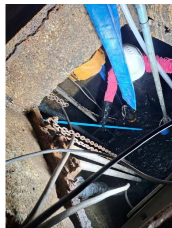
รูปที่ 2-7 สุ่มตะกอนส่วนเกินจากระบบบำบัดน้ำเสียไปกำจัด
