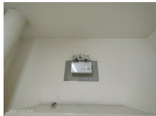
รูปที่ 2-20 ระบบไฟฟ้าสำรอง
