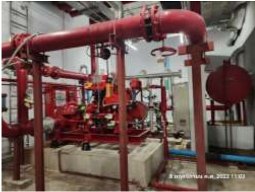
รูปที่ 46 ห้องเครื่องสูบน้ำดับเพลิง
