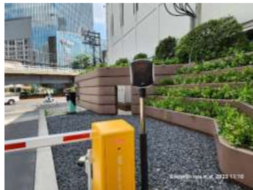
รูปที่ 32 ติดตั้งระบบควบคุม RFID
