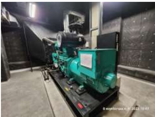
รูปที่ 23 ระบบไฟฟ้าฉุกเฉิน
