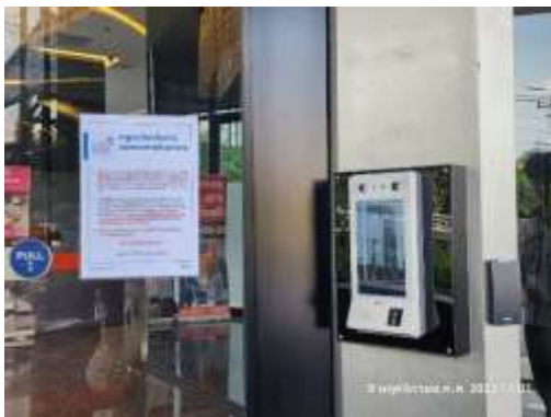
รูปที่ 37 ติดตั้ง Door monitoring
