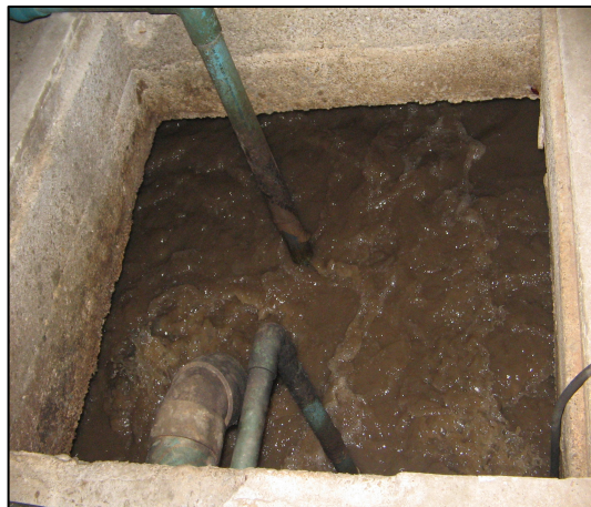
2.ระบบบำบัดน้ำเสียแบบตะกอนเร่ง (อาคาร C)
