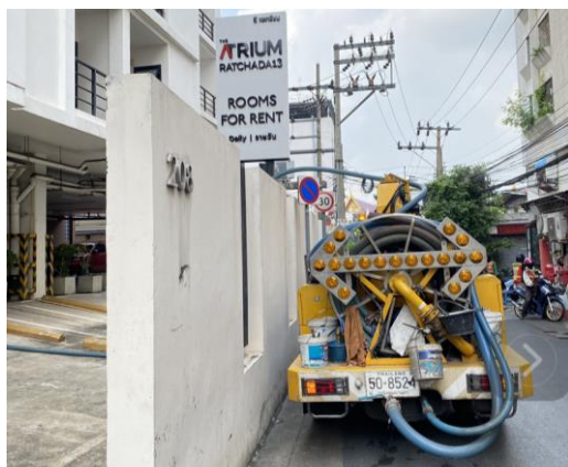
รูปที่ 2-4 การสูบน้ำจากตะกอน
