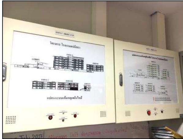
ภาพที่ 1-15 แผงควบคุมระบบสัญญาณ และแผงแสดงสัญญาณแจ้งเหตุเพลิงไหม้
