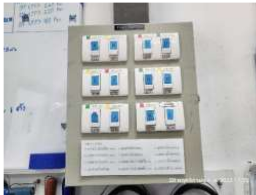
ภาพที่ 24 การแยกสวิตช์ควบคุมอุปกรณ์ไฟฟ้าแสงสว่าง
