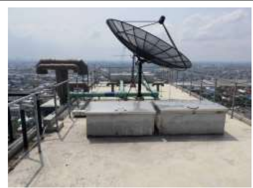
ภาพที่ 9 ถังเก็บน้ำใต้ดิน และถังเก็บน้ำชั้นดาดฟ้า เป็นถังคอนกรีตเสริมเหล็ก
