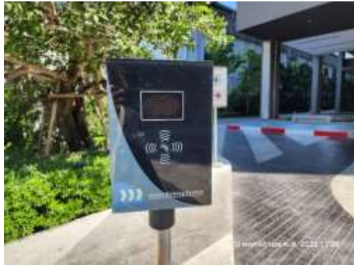
ภาพที่ 32 การใช้ระบบสัญญาณ Bluetooth แทนการ แลกบัตรผ่าน
