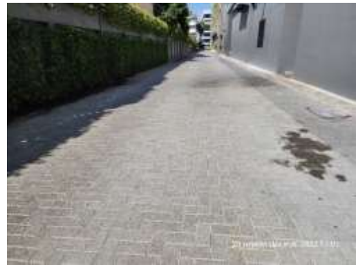
ภาพที่ 15 ถนนภายในโครงการปูด้วยบล็อกคอนกรีตพรุน (Porous Block Concrete)
