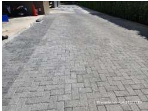
ภาพที่ 15 ถนนภายในโครงการปูด้วยบล็อกคอนกรีตพรุน (Porous Block Concrete)
