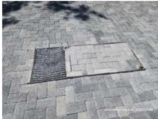
ภาพที่ 14 บ่อหน่วงน้ำเพื่อชะลอการไหลของน้ำส่วนเกิน
