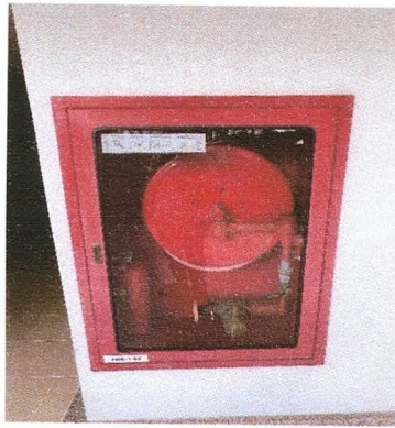
ภาพ 2-21 ตู้เก็บสายฉีดน้ำดับเพลิงพร้อมอุปกรณ์ (FHC) และถังเคมี
