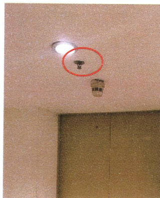
ภาพ 2-23 มีการติดตั้งระบบดับเพลิงอัตโนมัติ (Sprinkle System)
