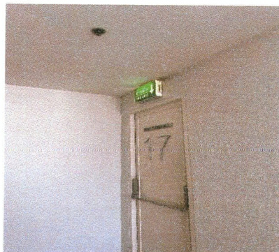
ภาพ 2-29 โครงการ มีประตูกันไฟกั้นระหว่างทางเดินภายในอาคารกับบันไดหนีไฟในแต่ละชั้น
