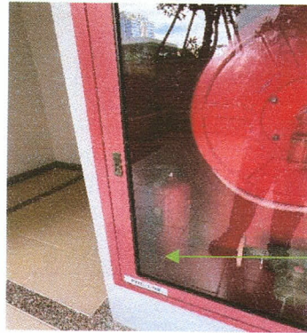
ภาพ 2-21 ตู้เก็บสายฉีดน้ำดับเพลิงพร้อมอุปกรณ์ (FHC) และถังเคมี
