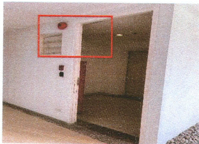
ภาพ 2-28 กริ่งสัญญาณเตือนภัย (Alarm Bell)
