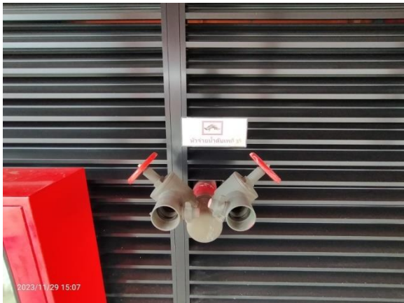
รูปที่ 2-27 หัวจ่ายน้ำดับเพลิงชั้นดาดฟ้า
