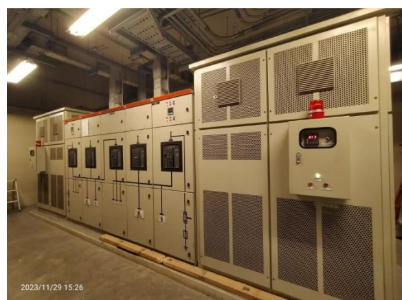
รูปที่ 2-37 หม้อแปลงไฟฟ้า
