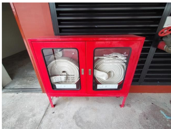
รูปที่ 2-29 ตู้เก็บสายน้ำดับเพลิงชั้นดาดฟ้า
