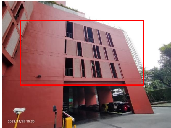
รูปที่ 2-57 ช่องระบายอากาศบริเวณลานจอดรถ
