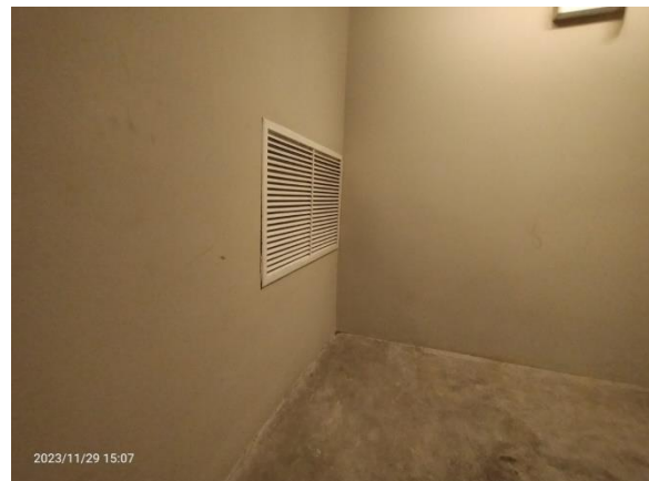
รูปที่ 2-18 ช่องระบายอากาศบริเวณบันไดหนีไฟ
