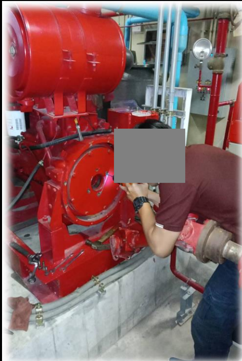
ตรวจเช็คบำรุงรักษาระบบเครื่องสูบน้ำ ดับเพลิงของอาคารชุด ชั้น G
