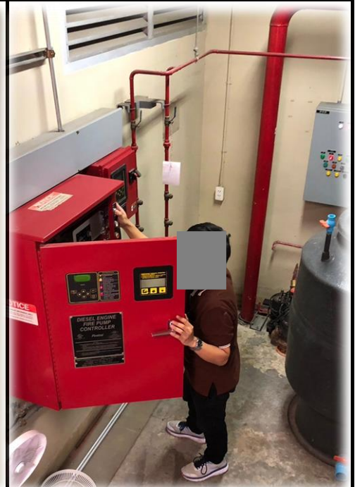
ตรวจเช็คบำรุงรักษาระบบเครื่องสูบน้ำ ดับเพลิงของอาคารชุด ชั้น G
