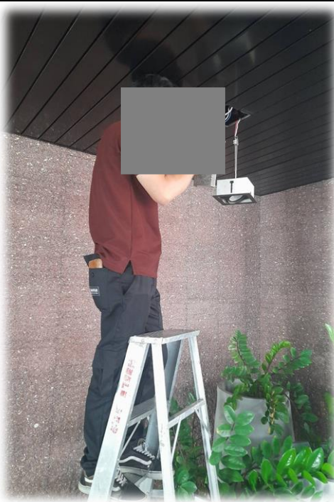
เปลี่ยนอุปกรณ์แปลงกระแสไฟฟ้าสำหรับไฟส่องสว่างบริเวณสระว่ายน้ำ ชั้น 5
