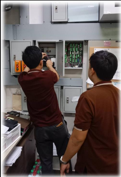
เปลี่ยนอุปกรณ์แปลงกระแสไฟฟ้าของระบบไม่กั้นทางขึ้น-ลงลานจอดรถยนต์ของอาคารชุด
