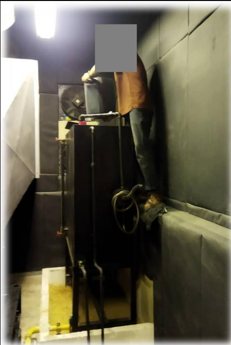
เติมน้ำมันดีเซลเพื่อบำรุงรักษาเครื่อง กำเนิดไฟฟ้าหลักของอาคารชุด
