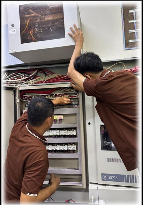
ตรวจเช็คระบบแจ้งเหตุเพลิงไหม้ของ อาคารชุด ภายในห้องนิติฯ ชั้น G
