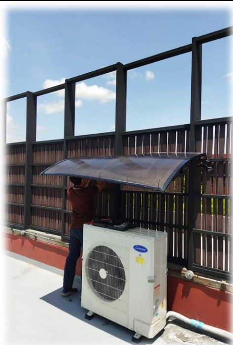
ติดตั้งหลังคา กันแดดคอมเพลสเซอร์ แอร์ของห้องควบคุมลิฟต์ บริเวณ ตาดฟ้า
