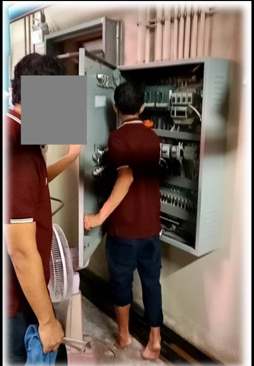
ตรวจเช็คบำรุงรักษาระบบเครื่องสูบน้ำ น้ำประปาของอาคารชุด ชั้น G
