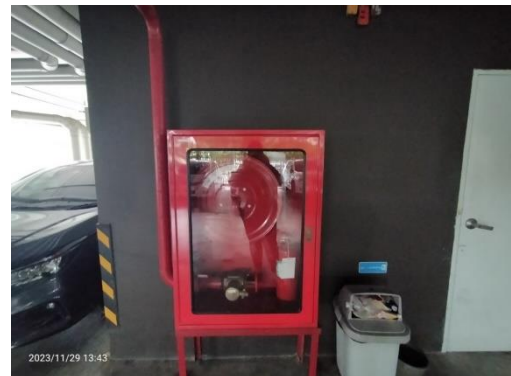
รูปที่ 2-33 ตู้เก็บสายดับเพลิงและถังดับเพลิง
