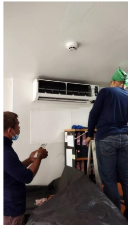
รูปที่ 2-65 ทำความสะอาดเครื่องปรับอากาศส่วนกลาง
