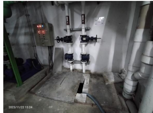
รูปที่ 2-45 ถังเก็บน้ำดับเพลิง
