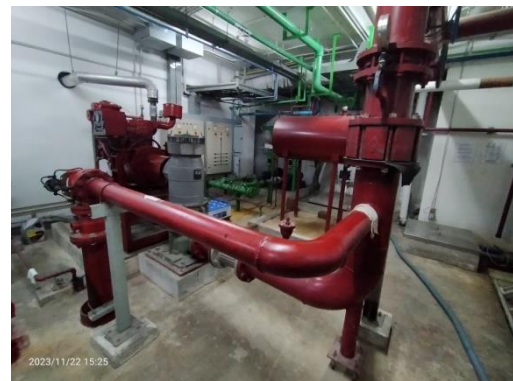
รูปที่ 2-47 ปิมน้ำใช้/ปิมน้ำดับเพลิง ชั้นคาตฟ้า
