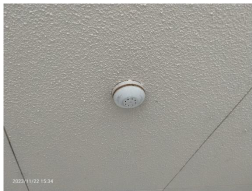
รูปที่ 2-24 เครื่องดักจับควัน
