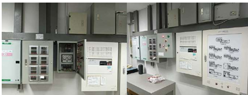
รูปที่ 2.19 ตู้คุมระบบ Timer ตั้งเวลาเปิด-ปิด (วันที่ 28 พ.ย. 2566)
