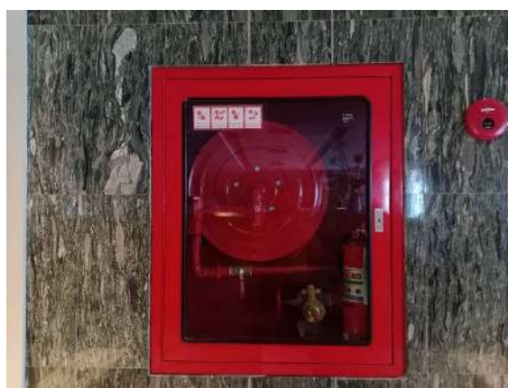
รูปที่ 2.22 ตู้เก็บสายฉีดน้ำดับเพลิงพร้อมอุปกรณ์ (วันที่ 28 พ.ย. 2566)
