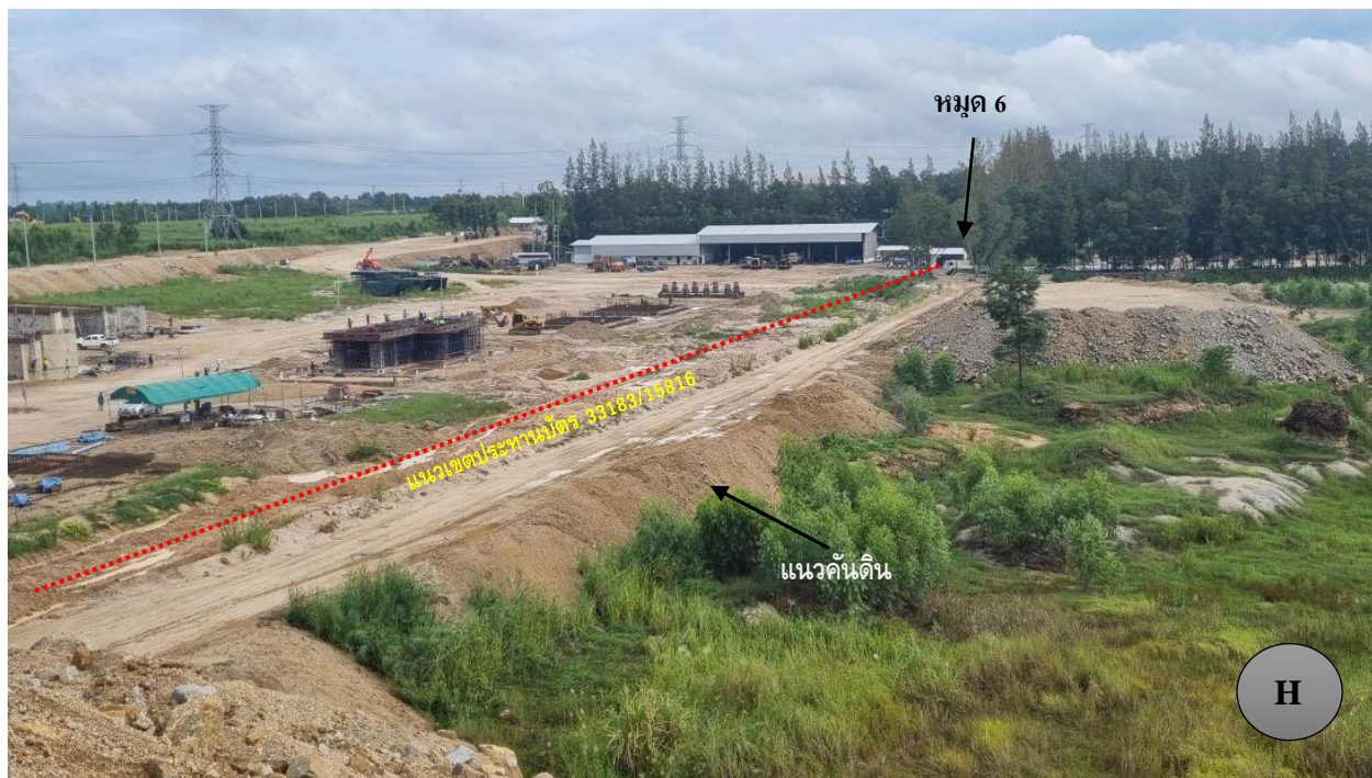
ภาพที่ 9 แสดงแนวคันดิน ระหว่างหลักหมุดประธานบัตรที่ 5 - 6 เตรียมการสำหรับการฟื้นฟูโดยการปลูกต้นไม้บน ชั้นบนได้ต่อไป
