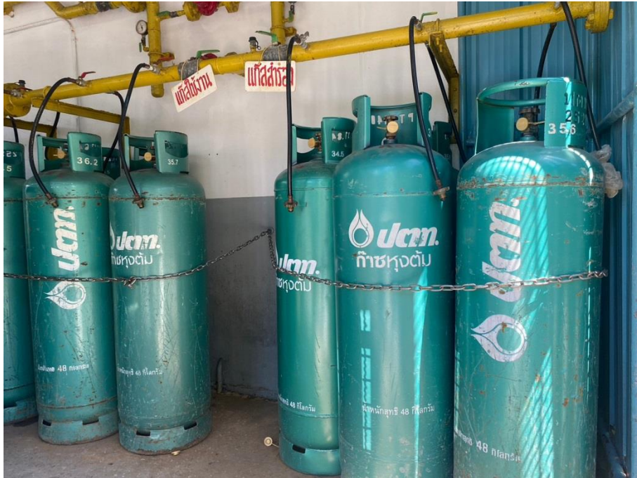
ภาพที่ 23 แสดงการรัดถังก๊าซ ภายในห้องเก็บก๊าซหุงต้ม
