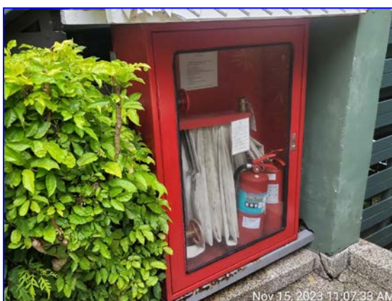
รูปที่ 2.15 ตู้เก็บสายฉีดน้ำดับเพลิงและถังดับเพลิง
