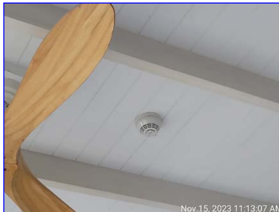
รูปที่ 2.17 ระบบตรวจจับควัน (Smoke Detector)
