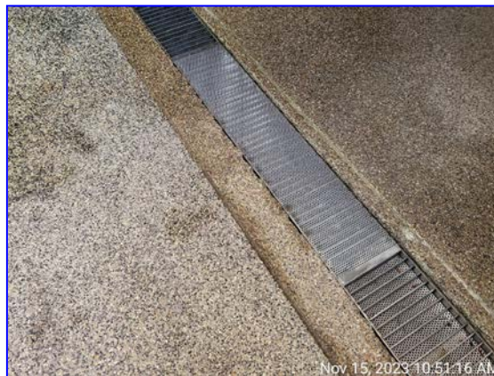
รูปที่ 2.38 ตะแกรงดักขยะ
