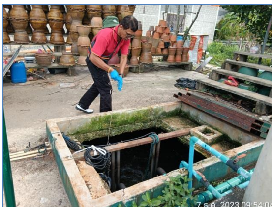
รูปที่ 3.1 การเก็บตัวอย่างน้ำทิ้งหลังผ่านระบบบำบัด
