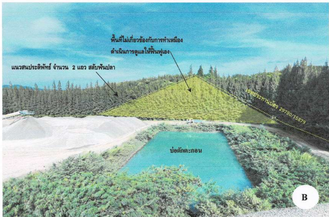
ภาพที่ 3 บ่อคักตะกอนขนาด 40X60X5 เมตร พื้นที่ประทานบัตร 29790/15879
