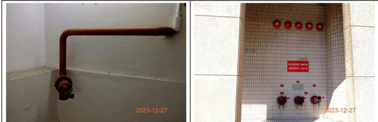
(10) จุดรับน้ำดับเพลิงภายในอาคาร (ทางหนีไฟ)
