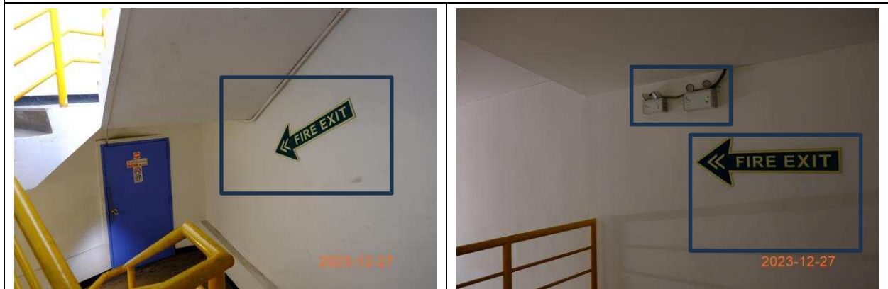
(3) ลูกศรบอกทางหนีไฟ และไฟส่องสว่างฉุกเฉินที่บันไดหนีไฟ (บริเวณพื้นที่สนันสนุน)
