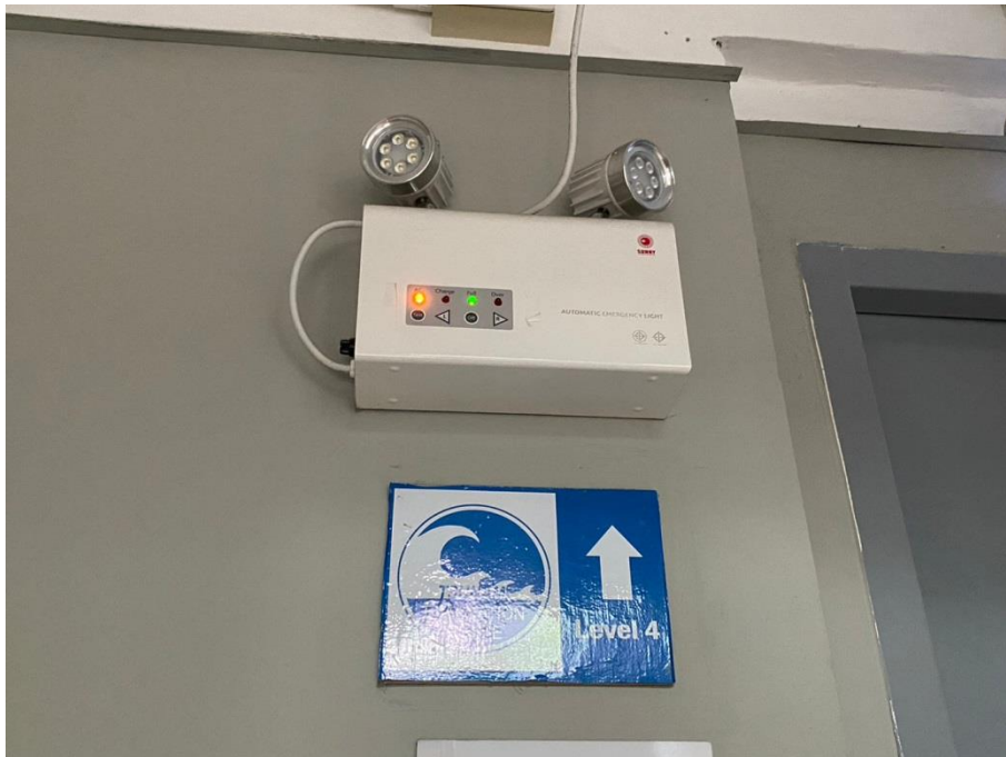
ภาพที่ 35 แสดงไฟส่องสว่างฉุกเฉิน
