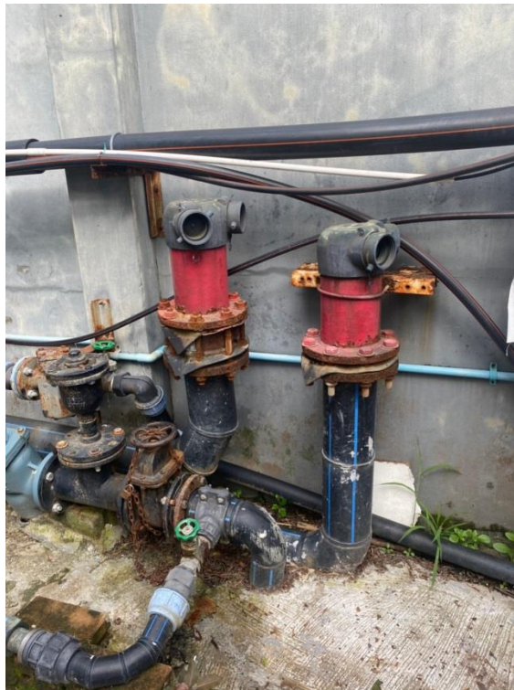
ภาพที่ 24 แสดงหัวรับน้ำดับเพลิงจากภายนอก
