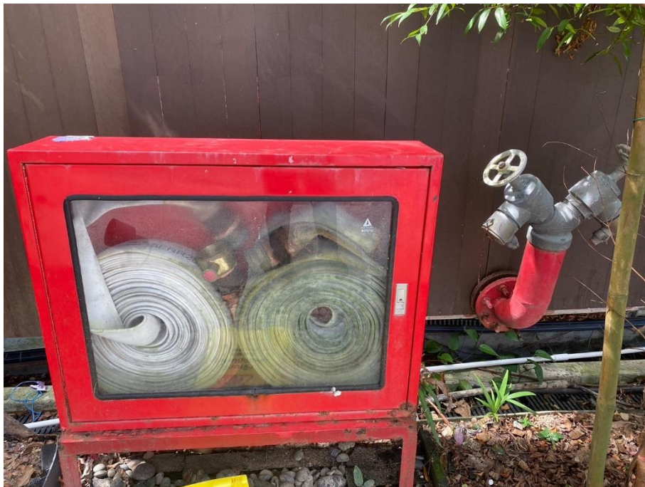
ภาพที่ 46 แสดงหัวและสายน้ำดับเพลิง
