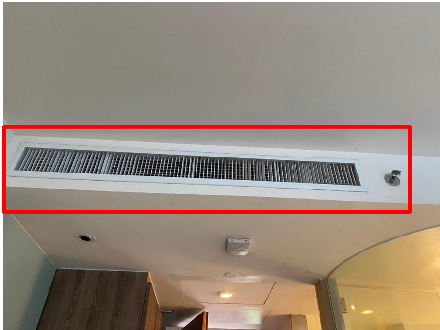
ภาพที่ 17 แสดงช่องเครื่องปรับอากาศและ Sprinkler ภายในห้องพัก
