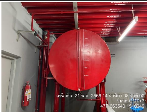
รูปที่ 39 ถังสำรองน้ำดับเพลิง
