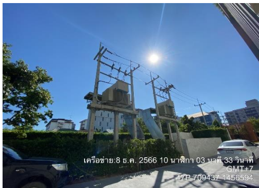
รูปที่ 50 หม้อแปลงไฟฟ้า
