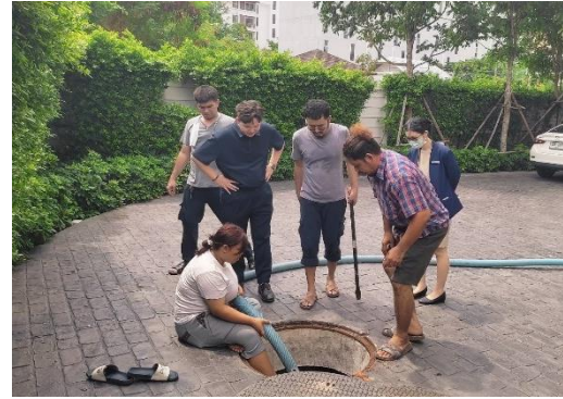
รูปที่ 8 สู้บกกกตะกอนออกจากระบบบำบัดน้ำเสีย
