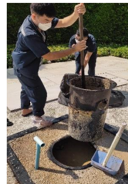
รูปที่ 56 เจ้าหน้าที่ทำความสะอาดถังดักไขมัน
