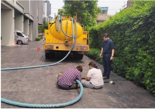
รูปที่ 8 สู้บกกกตะกอนออกจากระบบบำบัดน้ำเสีย
