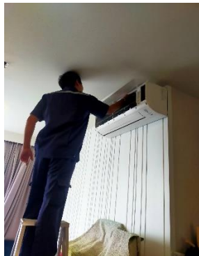
รูปที่ 3 เจ้าหน้าที่ทำความสะอาดเครื่องปรับอากาศ
