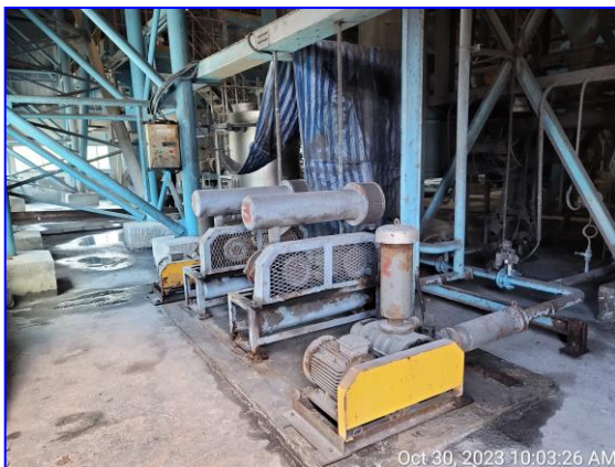
รูปที่ 2.19 ติดตั้งอุปกรณ์ดูดถ่านกัมมันต์ ( Activated Carbon ) เพื่อดูดซับ Dioxin
