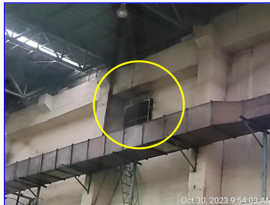
รูปที่ 2.18 ท่อลมดูดอากาศจากบ่อรับมูลฝอยเพื่อดูดอากาศจากบ่อรับขยะมูลฝอยเข้าสู่ห้องเผาไหม้
