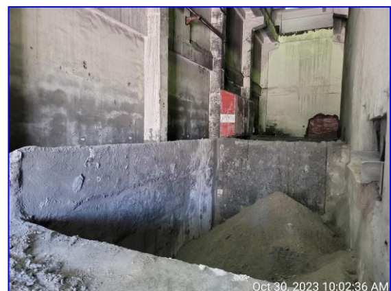
รูปที่ 2.23 บ่อคอนกรีตเก็บน้ำลอย – ถ้ำหนัก
