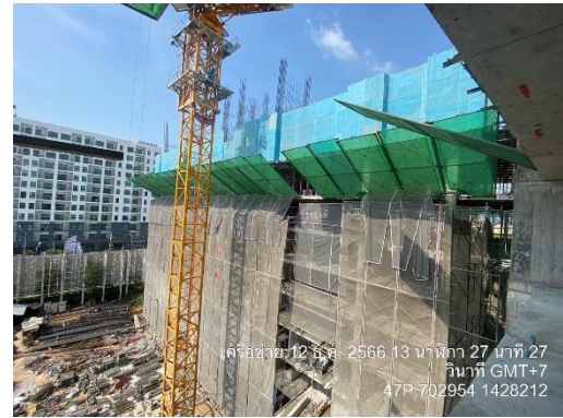
รูปที่ 33 ตะแกรงป้องกันวัสดุตกหล่น
