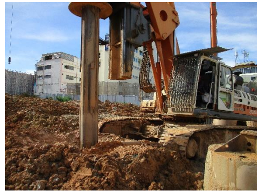
รูปที่ 18 เจาะเสาเข็ม (ปัจจุบันรื้อถอนออกแล้ว)
