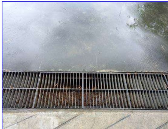
รูปที่ 2.46 รางระบายน้ำมีตะแกรงดักขยะ
