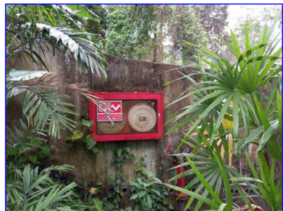
รูปที่ 2.29 หัวรับน้ำดับเพลิง และหัวจ่ายน้ำดับเพลิง
