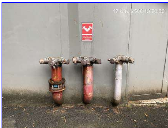
รูปที่ 2.29 หัวรับน้ำดับเพลิง และหัวจ่ายน้ำดับเพลิง
