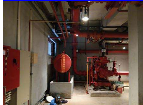
รูปที่ 2.31 ระบบ fire pump
