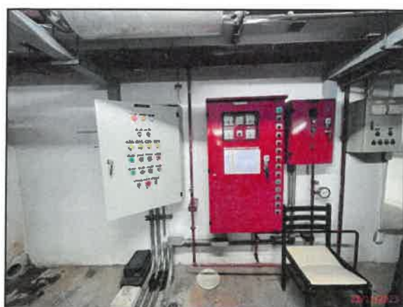
ตู้ควบคุมระบบ Fire pump
