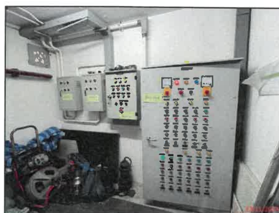
รูปที่ 36 ห้องควบคุมระบบบำบัดน้ำเสีย
