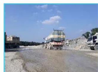
6. รถฉีดพรมน้ำตามแนวเส้นทางขนส่งแร่
