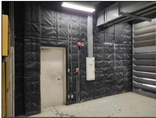
รูปที่ 2-9 ฉนวนกันเสียงบริเวณห้อง Generator และ ห้อง Chiller
