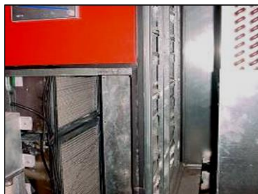
รูปที่ 2-3 การติดตั้งแผ่นกรองอากาศด้านข้างเครื่องส่งลมเย็น
