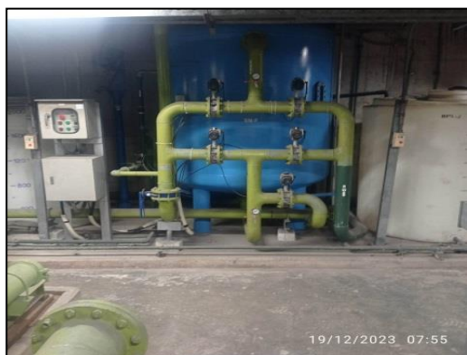
รูปที่ 2-14 เครื่องมือและอุปกรณ์ที่ใช้ในการปรับค่า pH ของน้ำทั้งจาก Softener
