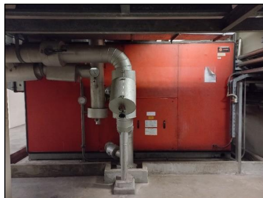
รูปที่ 2-2 ไดอะแกรมและภาพเครื่องส่งลมเย็น (Air Handling Unit AHU)
