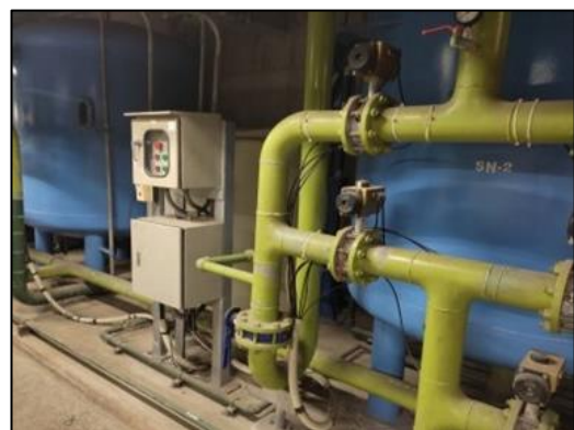
รูปที่ 2-14 เครื่องมือและอุปกรณ์ที่ใช้ในการปรับค่า pH ของน้ำทั้งจาก Softener
