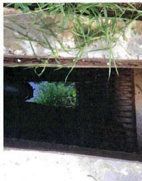
ภาพถ่ายที่ 2.2-63 ตะแกรงดักขยะที่บ่อตรวจสอบภาพน้ำ
