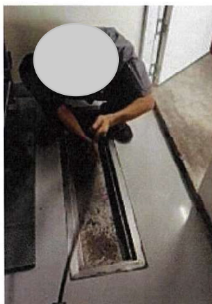
ภาพถ่ายที่ 2.2-20 เจ้าหน้าที่ตักไขมันในบ่อดักไขมัน (Grease trap tank)
