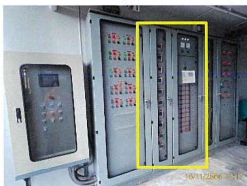
ภาพถ่ายที่ 2.2-21 มิเตอร์ไฟฟ้าของระบบบำบัดน้ำเสีย
