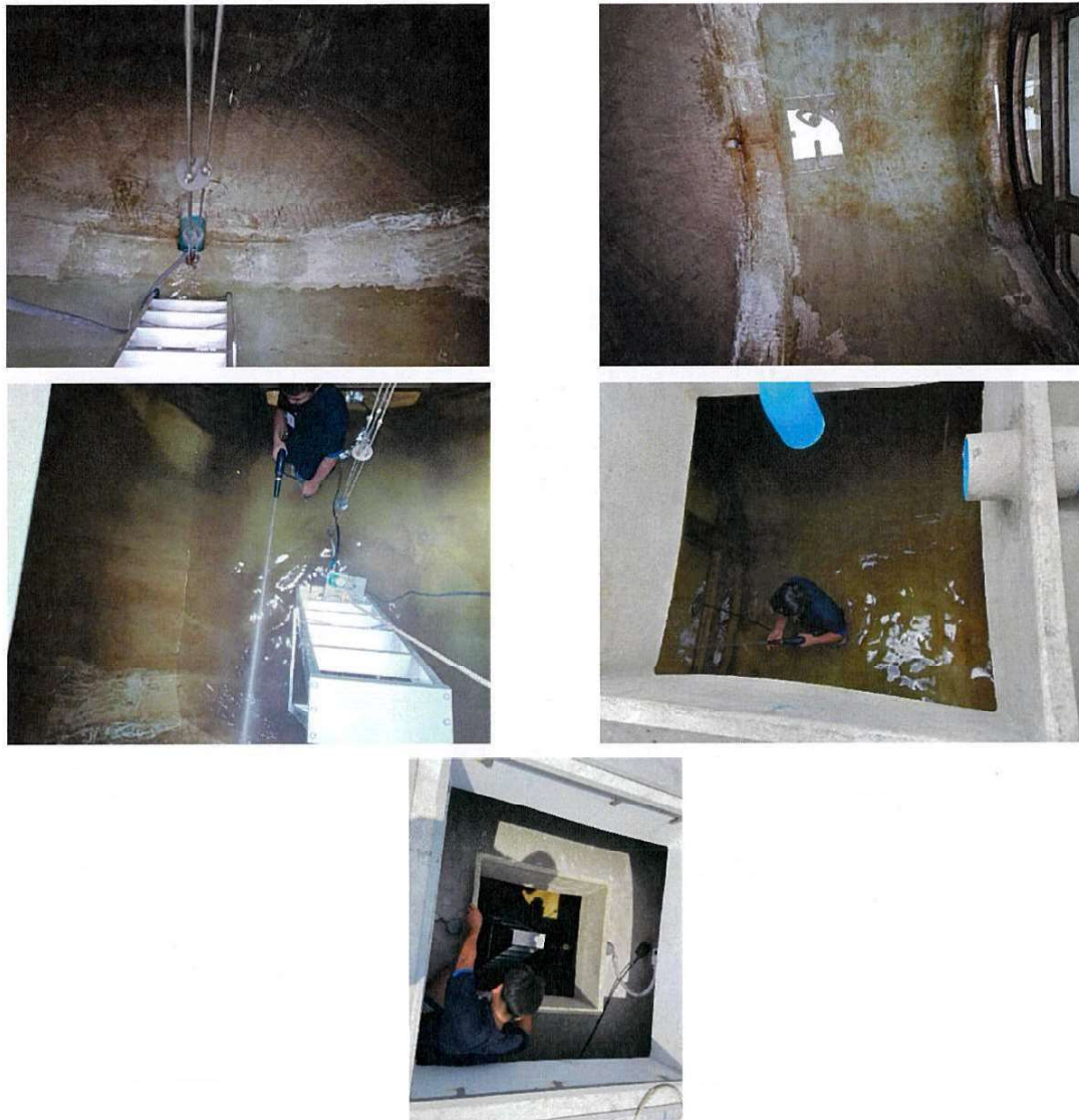
ภาพถ่ายที่ 2.2-76 การล้างทำความสะอาดถังเก็บน้ำใช้
