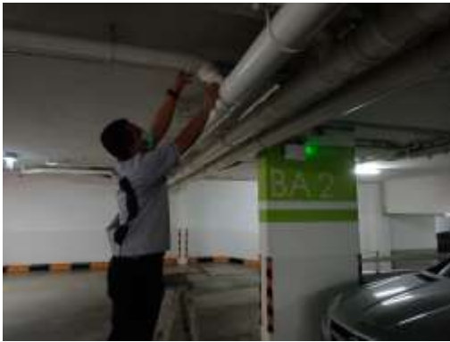
รูปที่ 15 ตรวจสอบรอยรั่วของท่อจ่ายน้ำ
