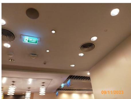
รูปที่ 2-20 การติดตั้งระบบแสงสว่างภายในอาคารไม่สูงกว่า 16 วัตต์ต่อตารางเมตร
