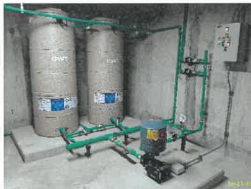
ปั๊ม และถังสำรองน้ำเพื่อการอุปโภค-บริโภคของร้านค้า
