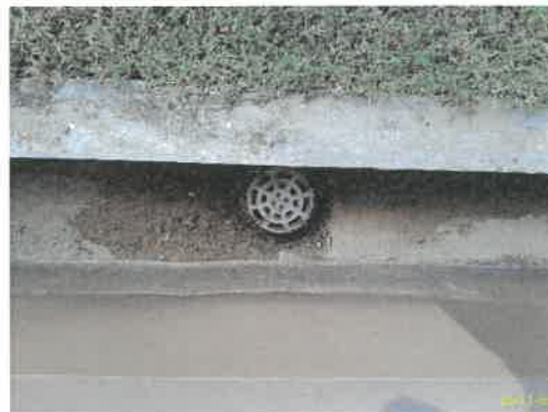
ท่อรวบรวมน้ำฝนชั้นดาดฟ้า
