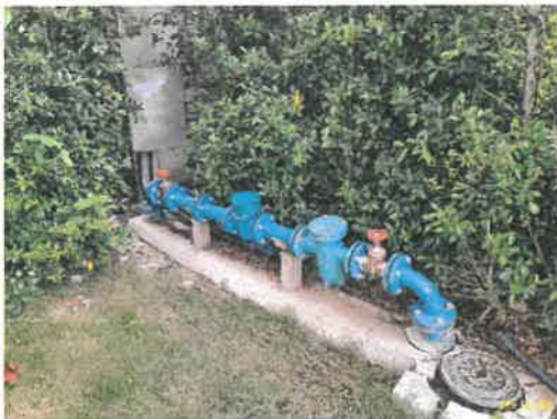
มิเตอร์น้ำสำหรับห้องพัก และพื้นที่ส่วนกลาง
