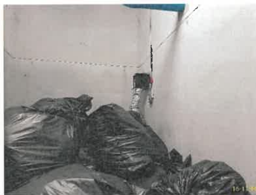
ท่อนำอากาศเสียไปบำบัดห้องพักขยะเปียก
