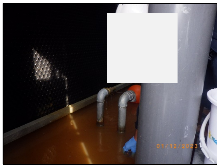
จุดที่น้ำไหลเข้ามาเติมในระบบ ชั้นดาดฟ้า
