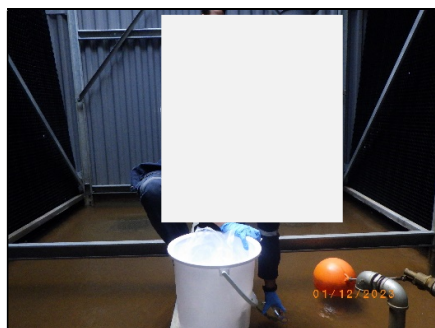
จุดที่น้ำไหลเข้ามาเติมในระบบ ชั้น 5
